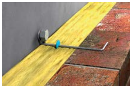
Фасадная кирпичная кладка
