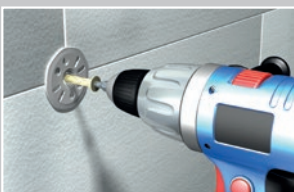
Geschraubter Dübel auf Polystyrol Platte
