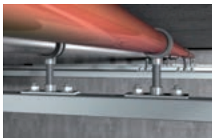
Подпятник на монтажной шине
