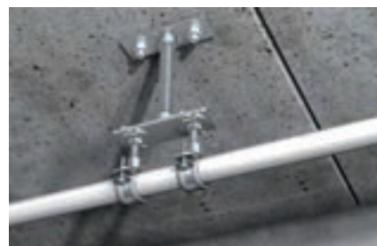
Неподвижное крепление пластиковой трубы
